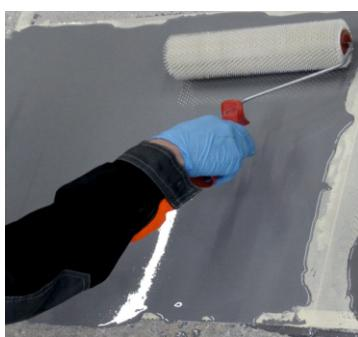
В процессе распределения материала необходимо контролировать состояние лезвия с зубцами. В случае его истирания необходимо заменить на новое, во избежание изменения предполагаемого слоя. Нанесение материала удобнее начинать от стены, противоположной к выходу из помещения. После распределения материал следует прокатать с помощью игольчатого (деаэрационного) валика. Это позволяет облегчить выход воздуха и процесс растекания материала по поверхности.
