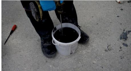
Протекающие реакции идут с выделением тепла, поэтому смесь саморазогревается в объеме (ведре) материала и процесс полимеризации ускоряется. Из этого следует, что время жизни материала в объеме и на поверхности значительно отличается и простой в ведре существенно ограничивает время на обработку материала.
