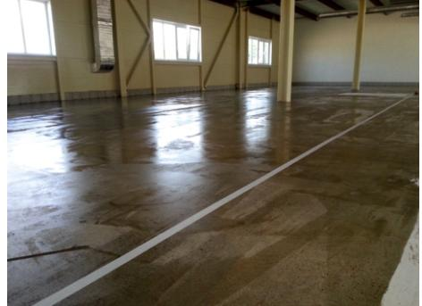
При нанесении следует внимательно следить за временем жизни материала. Полимерные материалы такого рода увеличивают вязкость со временем и следы от инструмента (валика или шпателя) перестают затекать.
