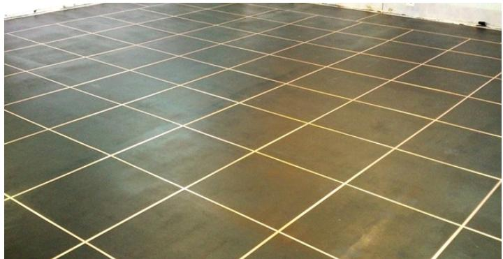
Самоклеящуюся медную ленту необходимо клеить по огрунтованной поверхности после окончания процесса полимеризации грунтовочного состава PRASPART® EP-P150. Лента клеится по контуру помещения (на расстоянии не более 0,1 м от стены или края помещения) и далее по поверхности с шагом (клетками) 1,5 – 3,0 м (в зависимости от конфигурации помещения).
